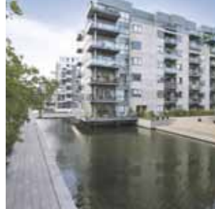
Weidekampsgade 45. Sag: NCS7520
