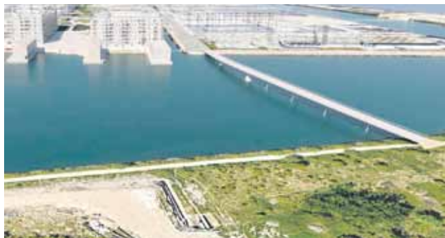
Forslag fem: 195 meter lang bro fra Teglholmegade med kurvet forløb til Fælled og ét åbningsbart fag.
