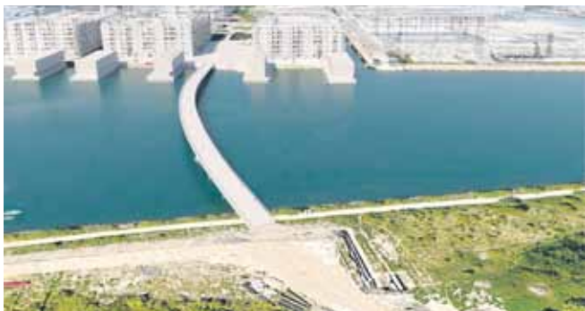
Forslag to: 230 meter lang bro fra Bydelspladsen med kurvet forløb til Fælled og ét åbningsbart fag.
