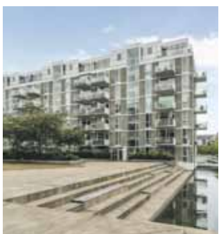
Islands Brygge Weidekampsgade 57, 3. 2
