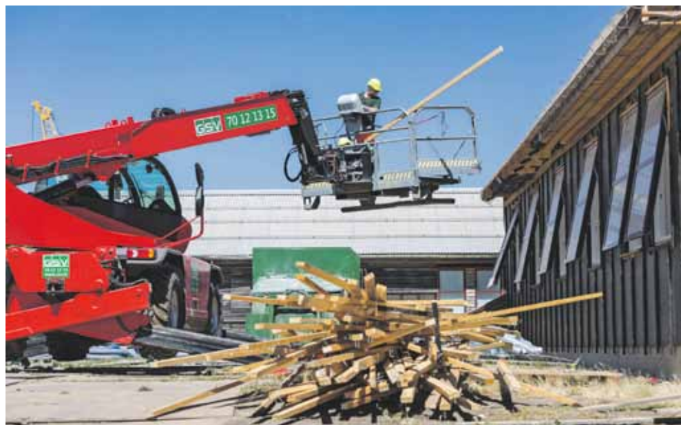
Nedrivningen af vandrehjemmet på Amager Fælled er gået i gang igen.
