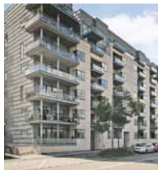
Islands Brygge Weidekampsgade 35, st.
