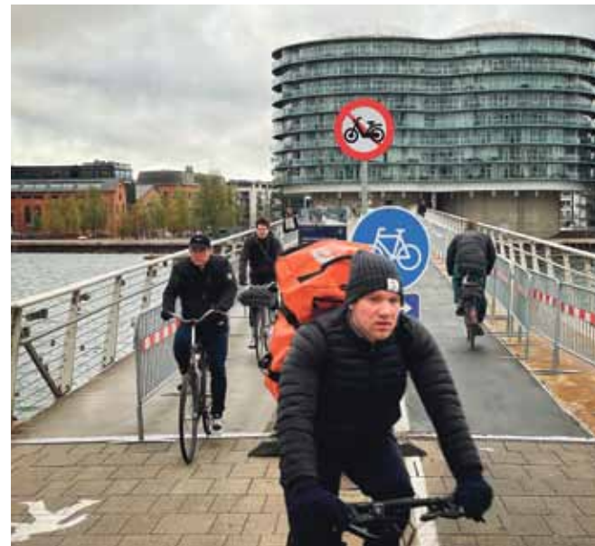
I månedsvi var dele af Bryggebroen afspærret, hvilket gjorde det til en nervepirrende oplevelse for både fodgængere og cyklister at krydse havnen. Nu er renoveringsarbejdet slut, men underlaget er ikke udført korrekt og skal derfor udbedres.
