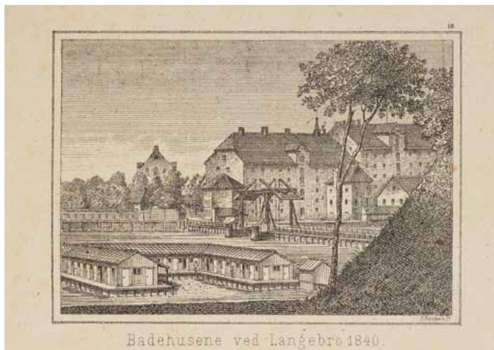
Holms Bade ved Langebro var et kompakt anlæg som bestod af retirader i lukkede kabiner placeret omkring et rektangulært bassin. Illustration: Ludvig Frederik Both.
