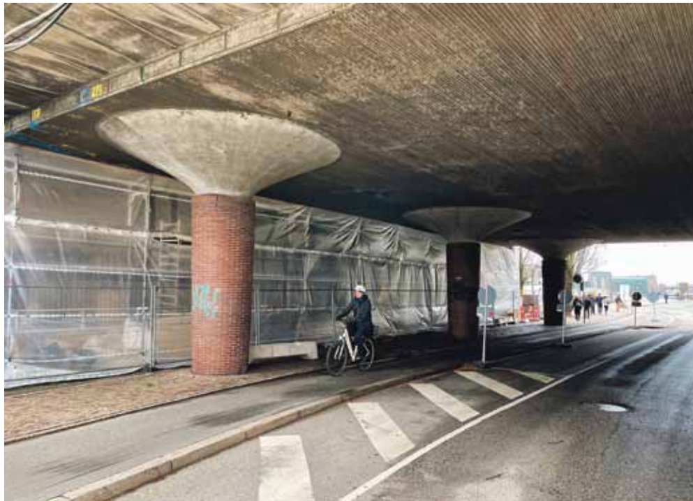
Samtlige lejemål under Langebro er blevet opsagt, mens der pågår renoveringsarbejde på broen.
