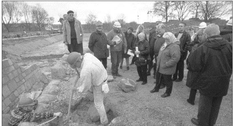
Det var et lille sluttet selskab, der overværede genetableringen af adgangsbroen.
