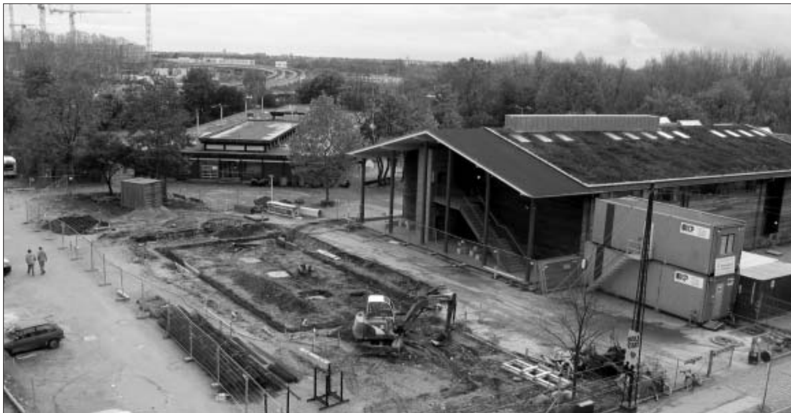
Lokalplan eller ej. Skolens udbygning er i gang på det område, som i forvejen tilhører skolen. Her er bygningsarbejderne i gang med en lille bygning, der skal stå færdig til foråret og som forbindes til nabobygningen via en gangbro.
