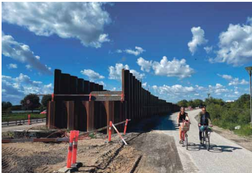
Ramperne til den nye cykel- og gangbro over Artillerivej tager form.
